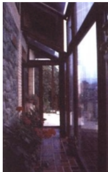
Staklenik s termoakumulacijskim zidom i podnim spremnikom topline
